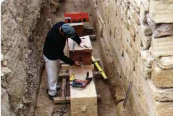
من أعمال ترميم معبد نكرح-براقش- البعثة الإيطالية
