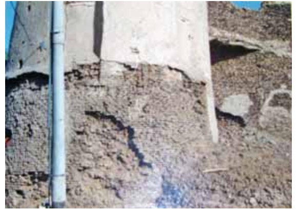
من أعمال ترميم قلعة زبيد
